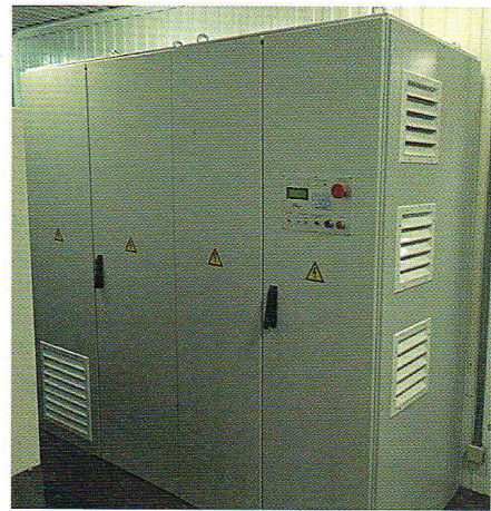
Рис. 11. Общий вид серийного АФКУ типа ЛМ-АФКС 6-0,85-70 УХЛ4
